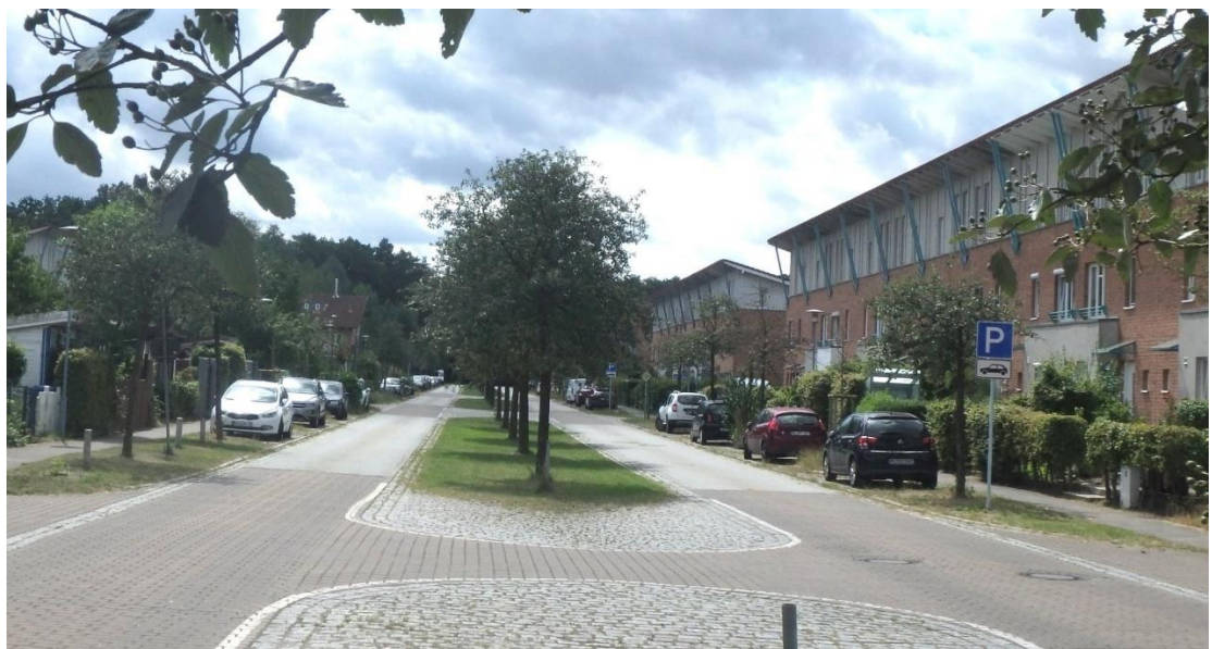
Abb. 97: Herrsburg Nord, Straße „Stausfeld“ mit Mulde in der Mitte des Straßenraumes zur Regenwassersammlung, -verdunstung und -versickerung unter Schatten spendenden Bäumen (Foto tBL)
