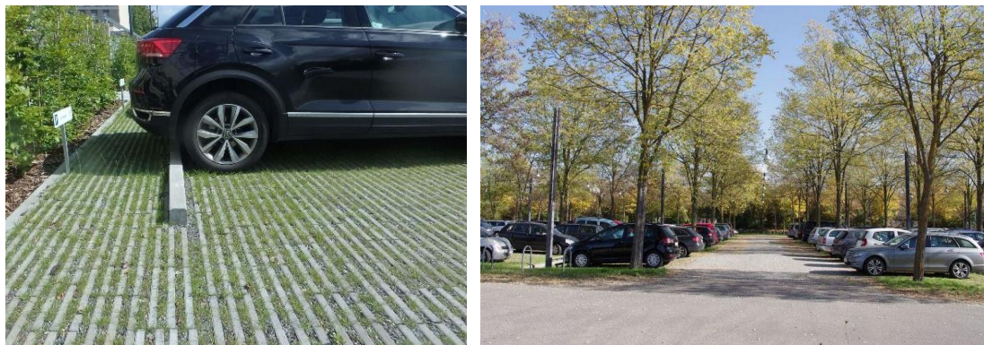
Abb. 95: Offenporiger Belag und Stellplätzen (Job-Center Lübeck, Walkmühlenweg, Planung + Foto tBL) Abb. 96: Parken unter Bäumen (Quelle: LfU, Bayerisches Landesamt für Umwelt, Augsburg)
