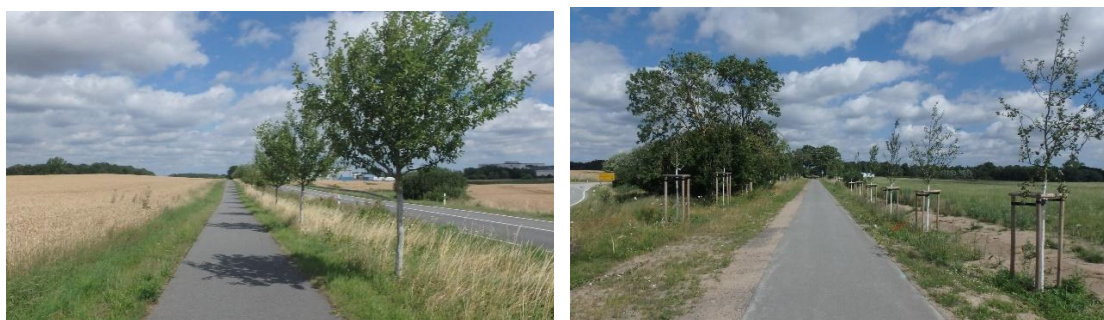
Abb. 65/66: Radweg entlang der L02 (nördlich der A20) der nach Süden fortgesetzt werden soll (F. tBL)
