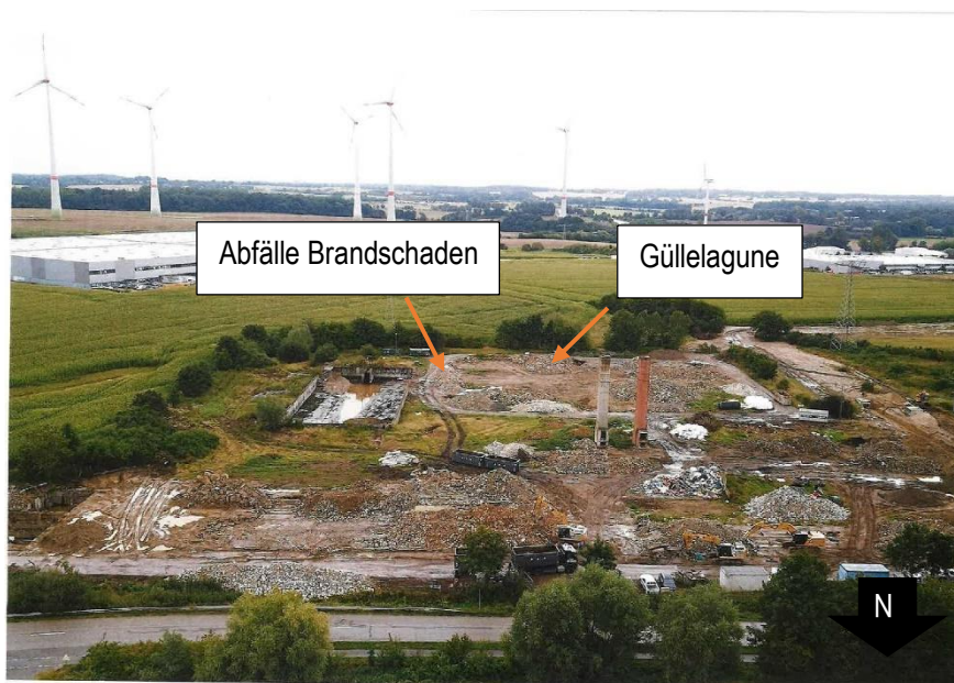
Abbildung 10: Luftbildaufnahme – Kennzeichnung Brandschadensrückstände (Quelle LGE)
