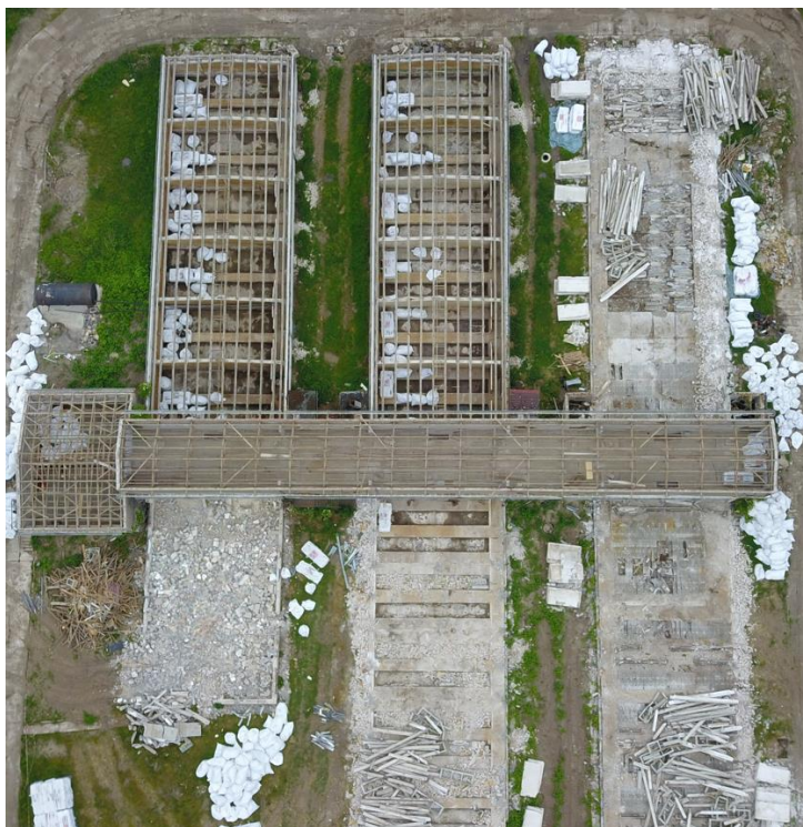
Abbildung 22: Abschluss Schadstoffsanierung – Beginn konstruktiver Rückbau Schweineställe
