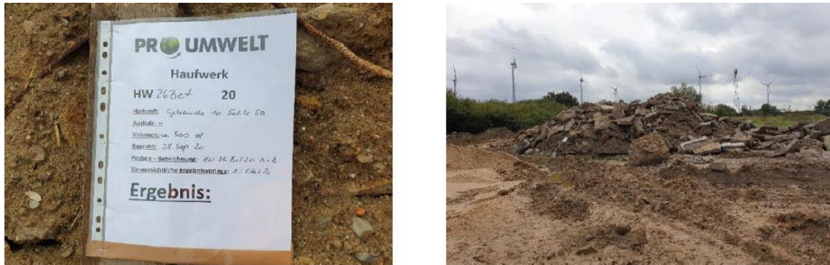
Abbildung 25: Haufwerksbildung mineralischer Rückbaubsubstanz
