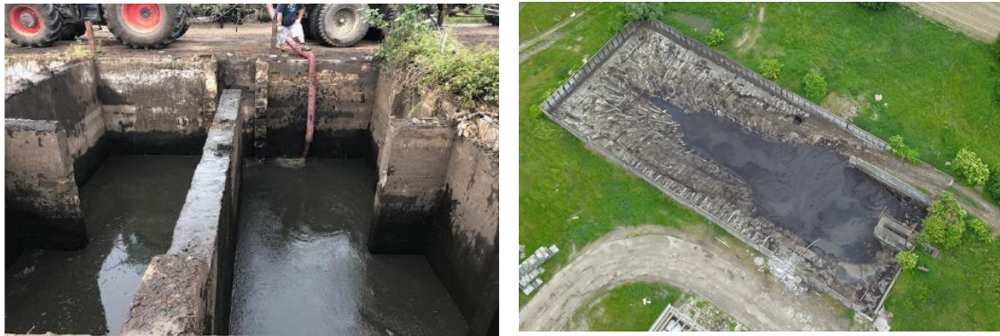
Abbildung 23: Abpumpen der Grubeninhalte / Güllelagune noch nicht vollständig entleert
