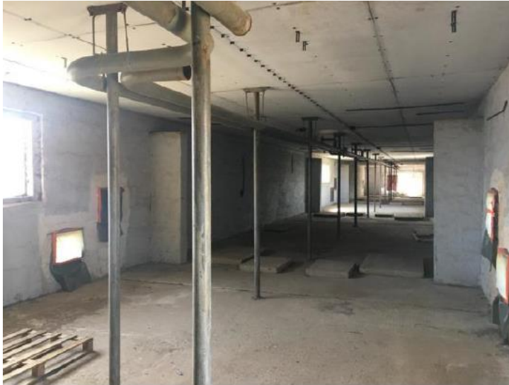
Abbildung 17: Entkernung Mittelgang Kälberstall Geb. 10
