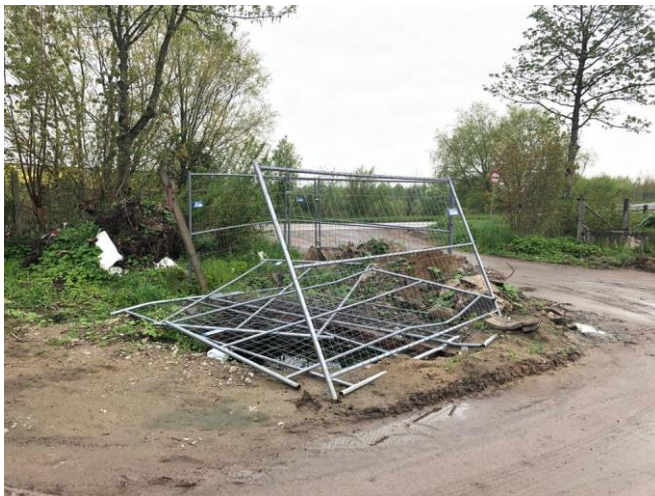
Abbildung 7: Grube nördlicher Randbereich des Rückbauareals
