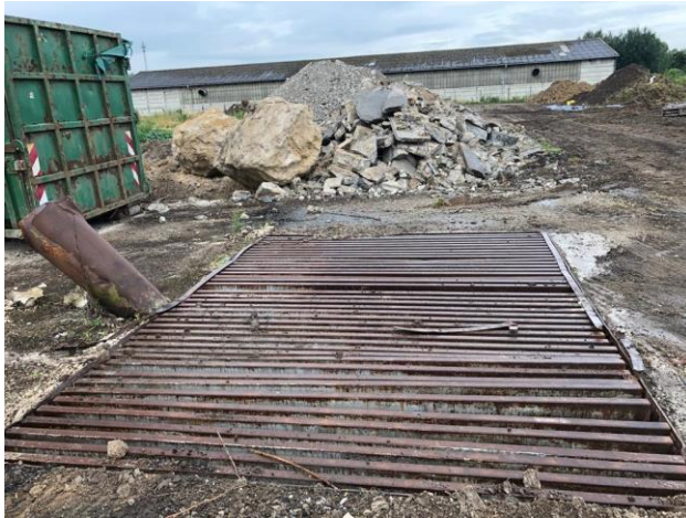
Abbildung 6: Grube westlich Geb. 14
