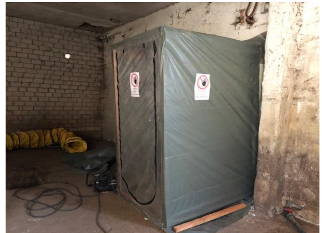
Abbildung 18: Asbestarbeiten – Einhausung, Personenschleuse, Arbeitsbereich, Unterdruckhaltung
