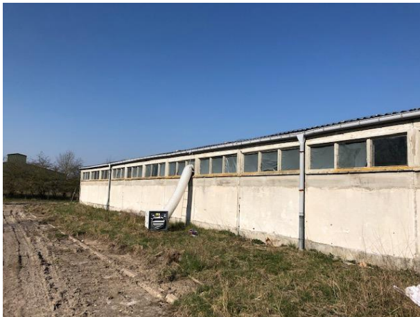
Abbildung 18: Asbestarbeiten – Einhausung, Personenschleuse, Arbeitsbereich, Unterdruckhaltung
