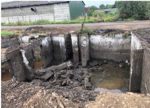
Abbildung 24: Rückbau der Gruben (G2)
