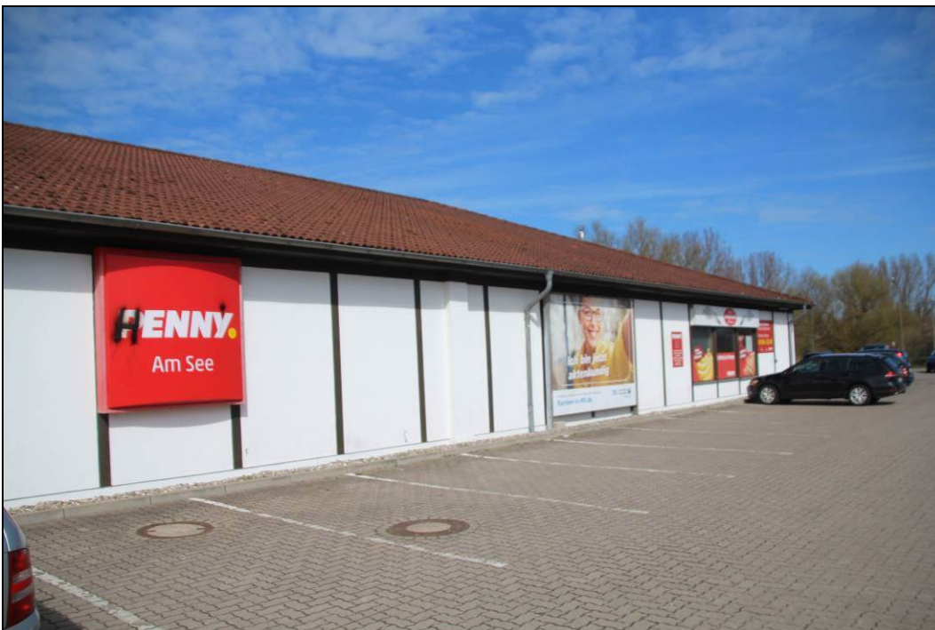
Abbildung 3: Ansicht des Traufbereiches aus Richtung Osten.
