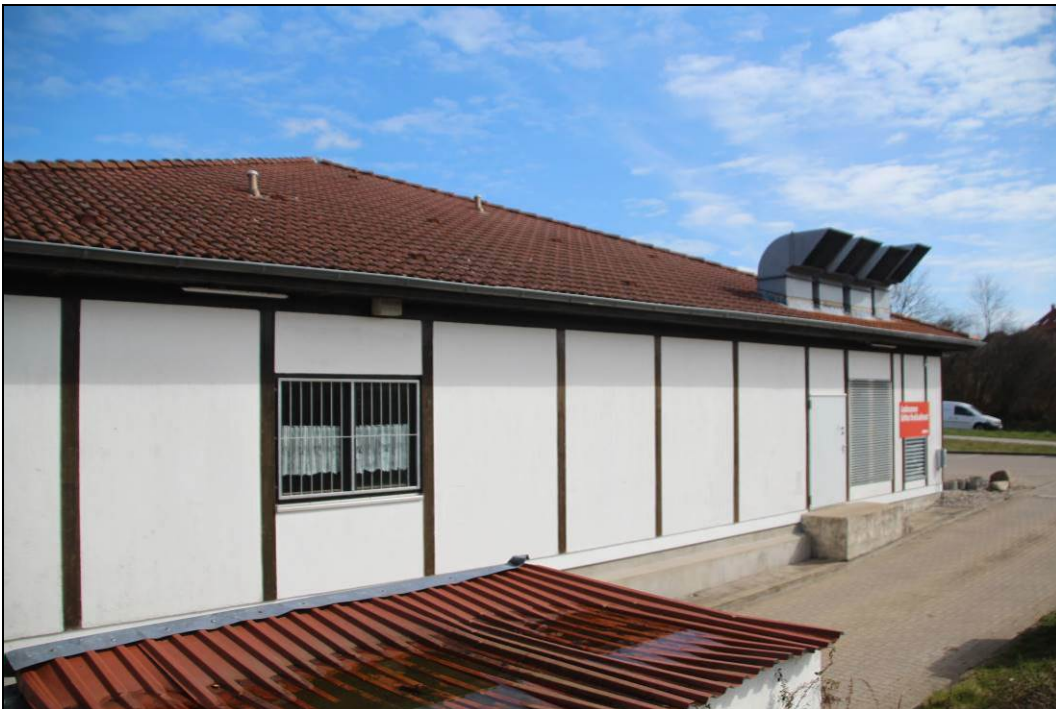
Abbildung 7: Ansicht aus Richtung Süden.
