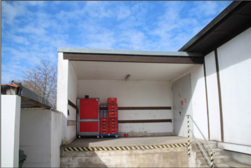
Abbildung 6: Lieferzufahrt im Südwesten.
