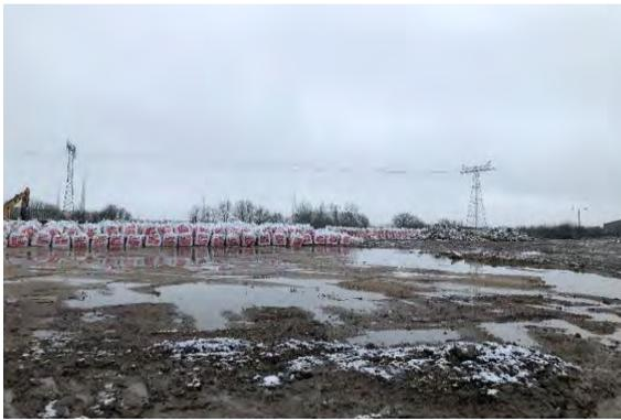
2.600 t asbesthaltiger Boden abgepackt
