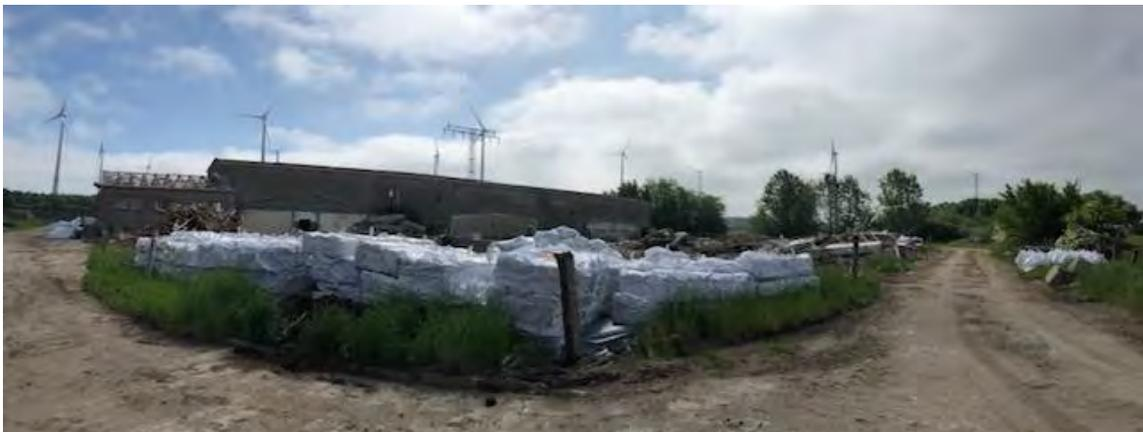
Abb 25: Blick Richtung Osten; BigBags mit AZ - Abfällen, dahinter niedergelegter Bereich Geb. 8 ,2 ,4 m.: Gebäude 6
