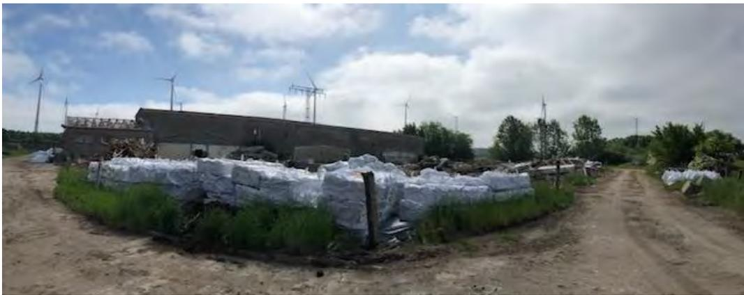
Abb 25: Blick Richtung Osten; BigBags mit AZ - Abfällen, dahinter niedergelegter Bereich Geb. 8 ,2 ,4 m.: Gebäude 6
