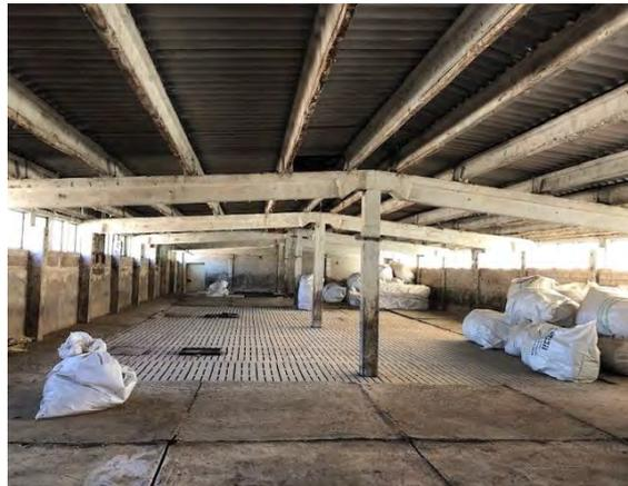
F 2 + F 3: Gebäude 5 nach Asbestzementrückbau im Innenbereich
