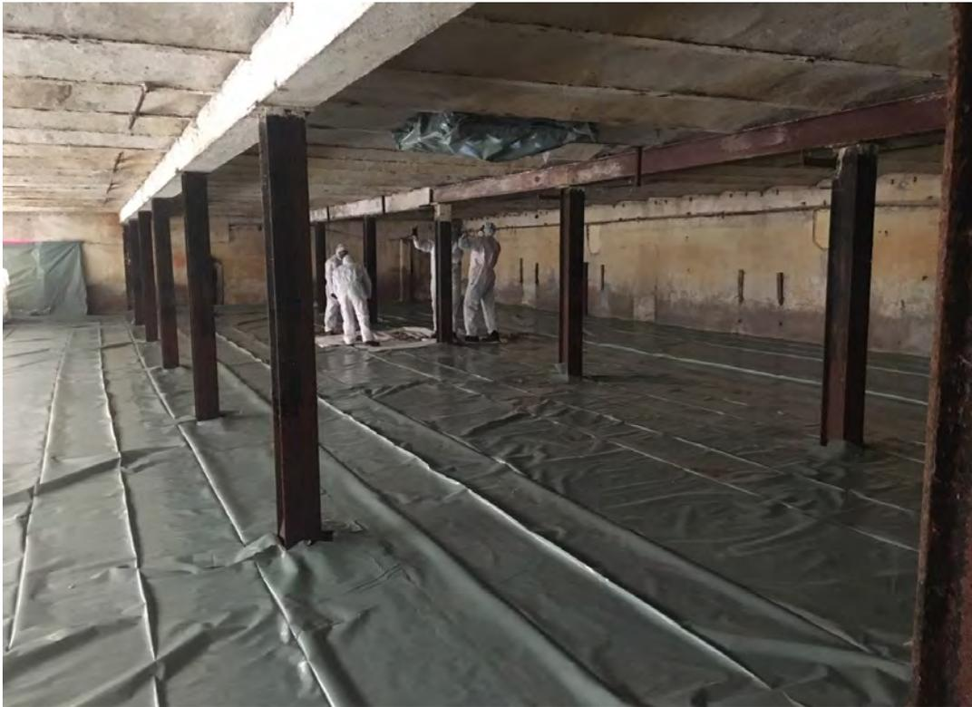
13.05.20: Geb. 10 Abnahme des Sanierungsbereiches Unterzüge Asbest schwach geb.
